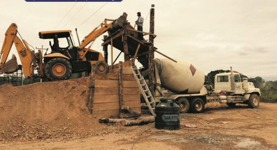
Preparación de mezcla para pavimento rígido
